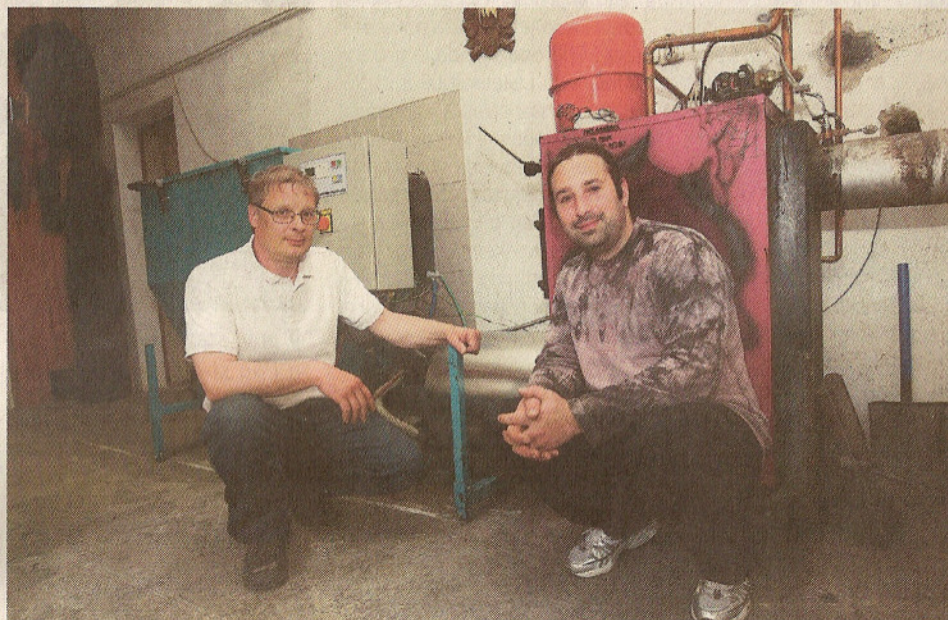
Robert Mramor (levo) in Mitja Modic pri svojem gorilniku na biomaso Intellitherm, ki sta ga montirala na staro peč.
